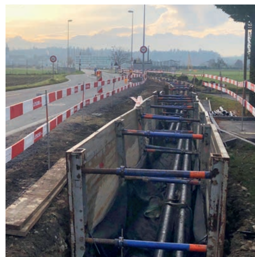
Weiterer Ausbau des Fernwärmenetzes in Emmen und Emmen Dorf.
