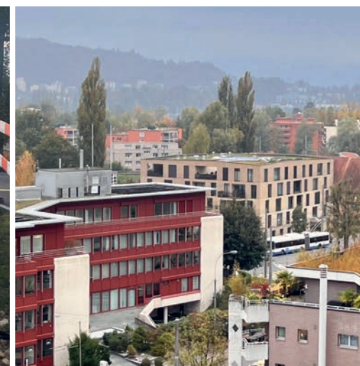
See-Energie auch für das Luzerner Würzenbach-Quartier, nach dem Ja zum Sonderkredit über sechs Millionen Franken am 25. September 2022.
