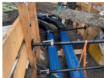
Leitungsbau für erneuerbare See-Energie im Zentrum von Luzern.
