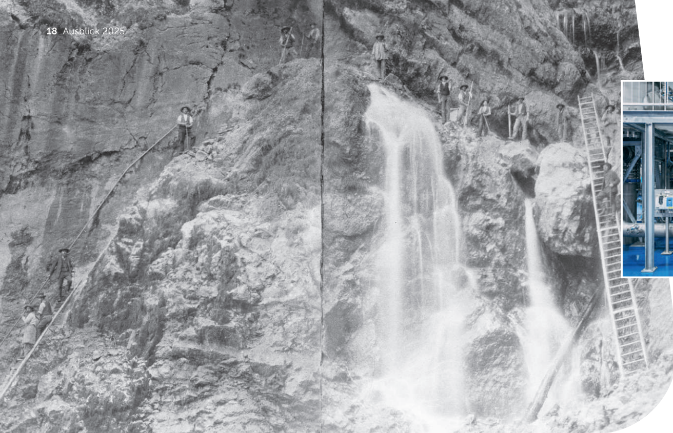
1889: Fassung der Bründlenquelle im Eigenthal.
