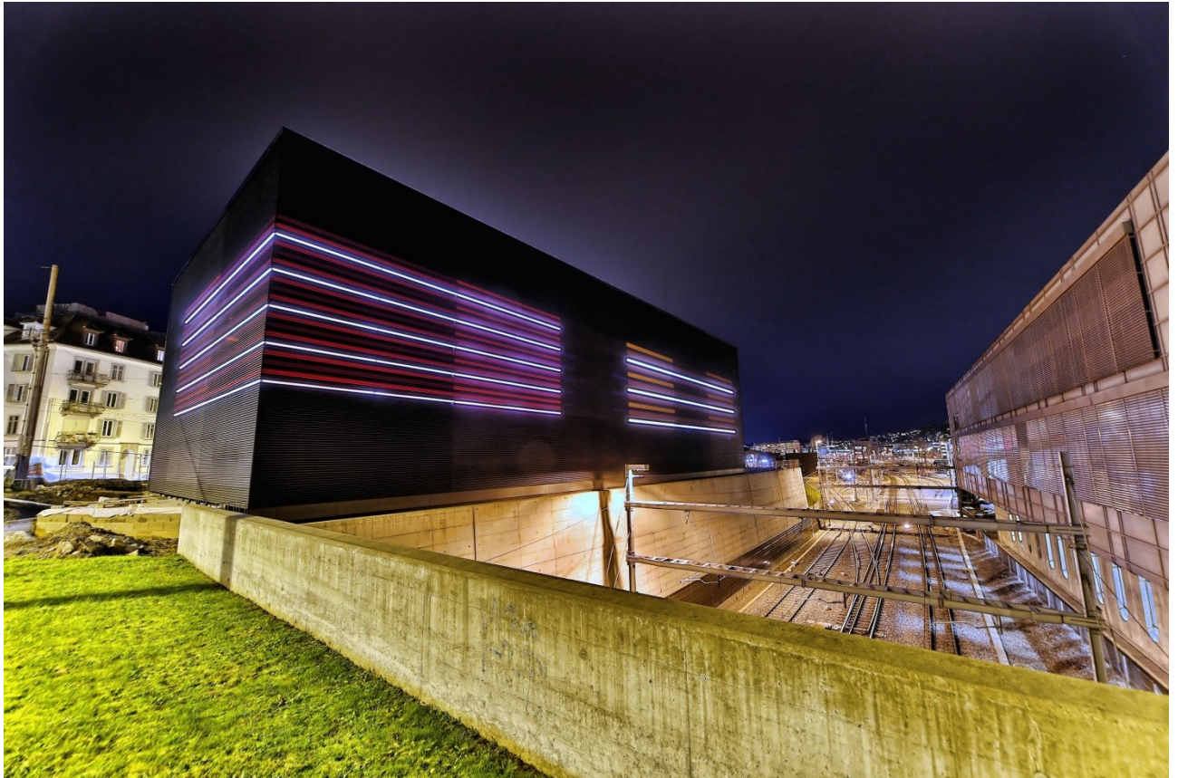
Bild: Das beleuchtete Kunstwerk Unterwerk Steghof
